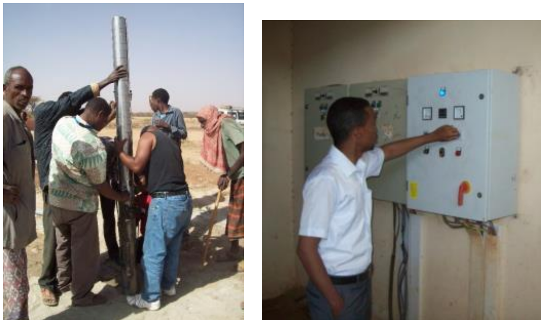
写真 11：水中モーターポンプ（写真左）とコントロールパネル（写真右）
