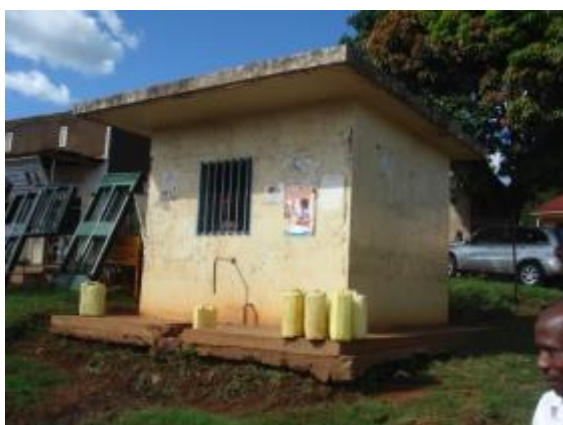
写真8（左）：キオスク 盗難、いたずら防止のため蛇口を屋内に設置している
