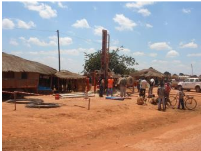
写真 10 : 深井戸の施工状況
