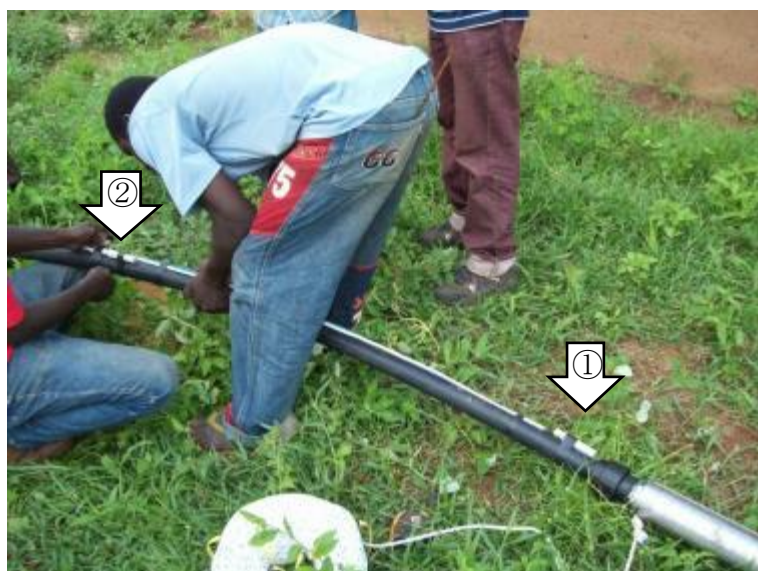
写真 12 : 水中モーターポンプと水位センサー
