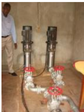
写真 6 : 修理された動力モーターポンプ (左) と公共水栓 (右)
