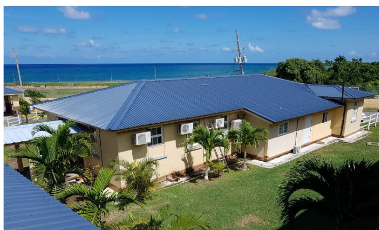
省エネ機器導入予定の地方保健施設
