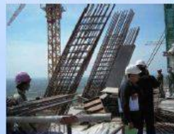
マレーシア建設現場の安全監督の実習
