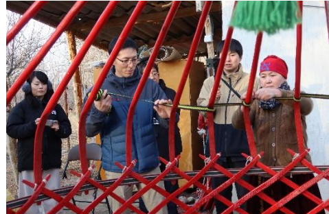
(キルギスの伝統家屋を組み立てる様子)
