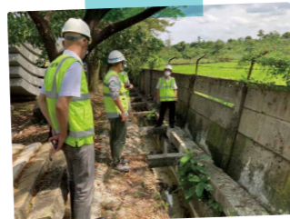
インフラ被害状況調査
