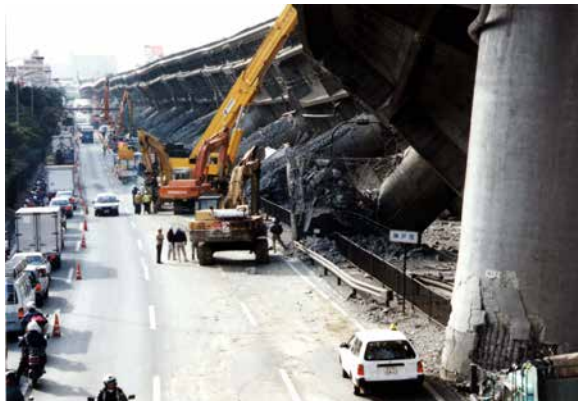
横倒しの阪神高速道路 (神戸市東灘区) 写真提供：人と防災未来センター
