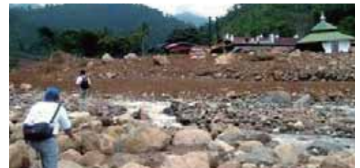
Survei dan investigasi kondisi lapangan pasca-banjir bandang di Jember (Januari 2005)
