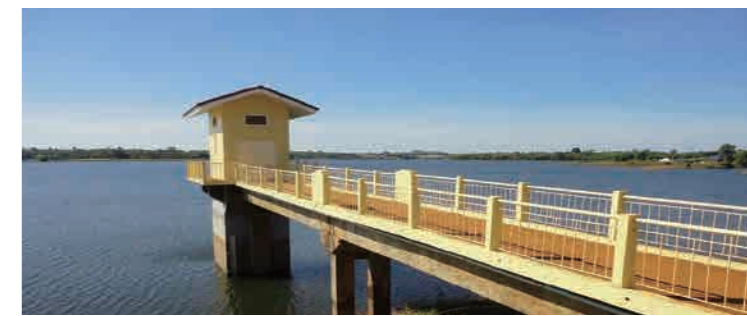
オチュム第一ダムの取水塔
