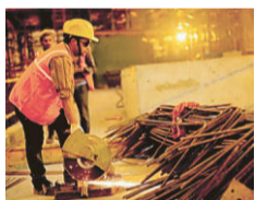
工事現場では事故が起きないように細心の注意を払います
