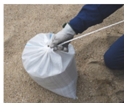
Наполните мешок для песка и затяните верх, потянув за шнурок
