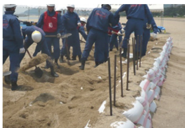
Укладка мешков с песком
