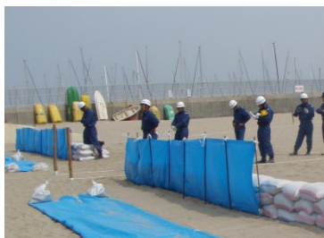
Укладка мешков с песком с применением брезентовой стенки
