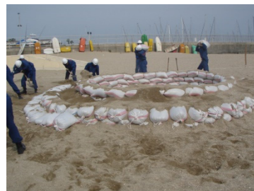
Укладка мешков с песком множественными кругами
