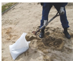
Наполните мешок для песка и затяните верх, потянув за шнурок
