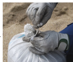
Набросьте шнурок на палец, чтобы сделать петлю. Обмотайте шнурок вокруг горлышка мешка 2-3 раза. Проденьте шнурок через петлю и затяните узел.
