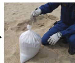
Набросьте шнурок на палец, чтобы сделать петлю. Обмотайте шнурок вокруг горлышка мешка 2-3 раза. Проденьте шнурок через петлю и затяните узел.
