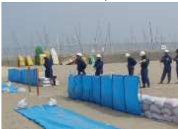
Apilamiento de sacos de arena con una pared de lona impermeable
