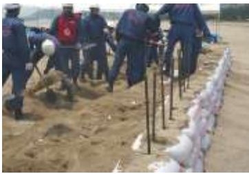
Apilamiento de sacos de arena
