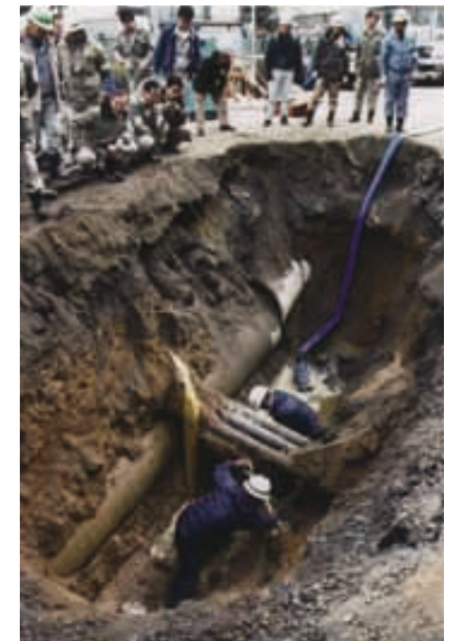
Работы по восстановлению важнейших линий коммуникаций (предоставлена компанией «Кобе-синбун»).
