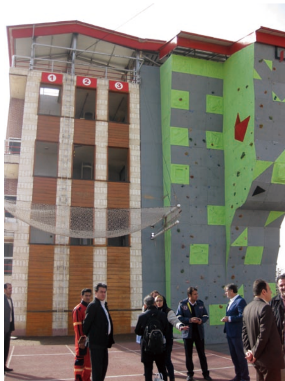
帰国研修員が建設した消防訓練施設
