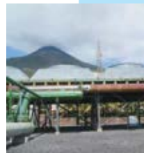
Planta Geotermica Momotombo
