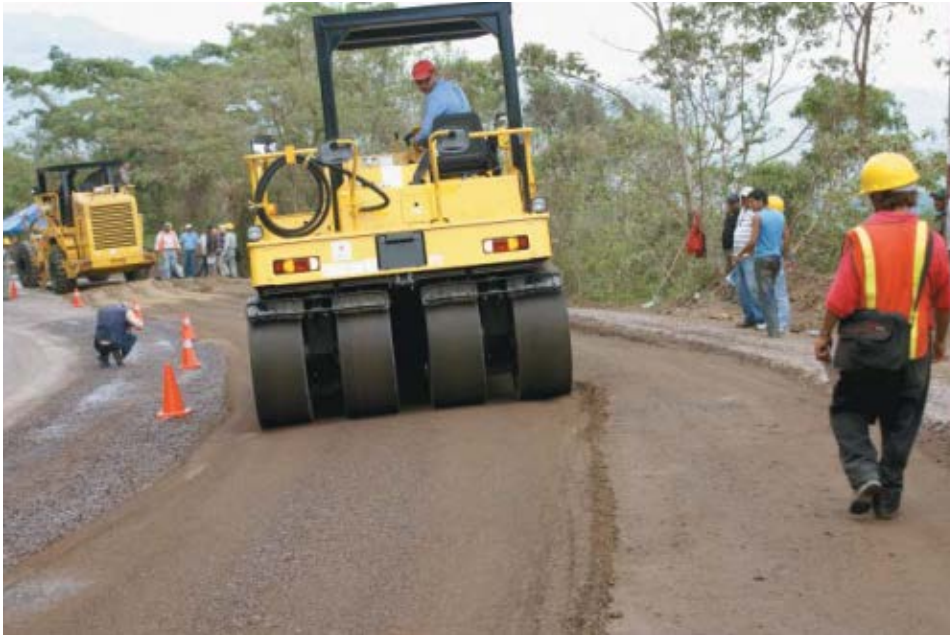
Maquinaria donada por Japón trabajando en la habilitación del tramo Santa Emilia- El Tuma-La Dalia.
