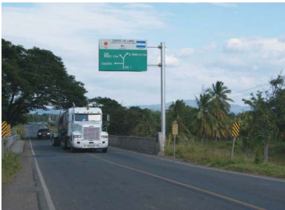
Puente Las Limas ubicado en la carretera Managua-El Rama, construido por Japón en el año 2008.
