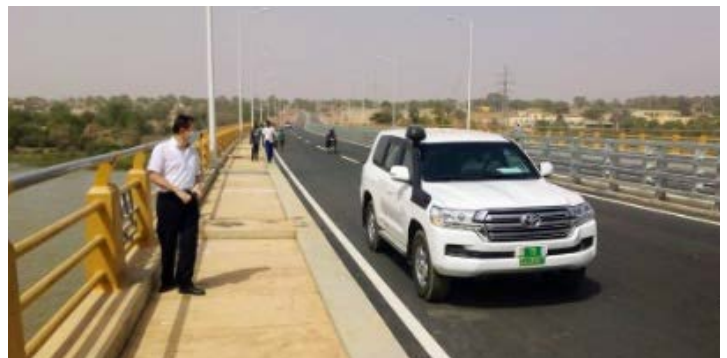
2月竣工のニアメ第3橋
