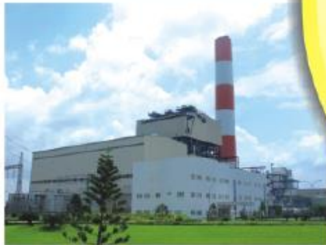
オモン火力発電所
