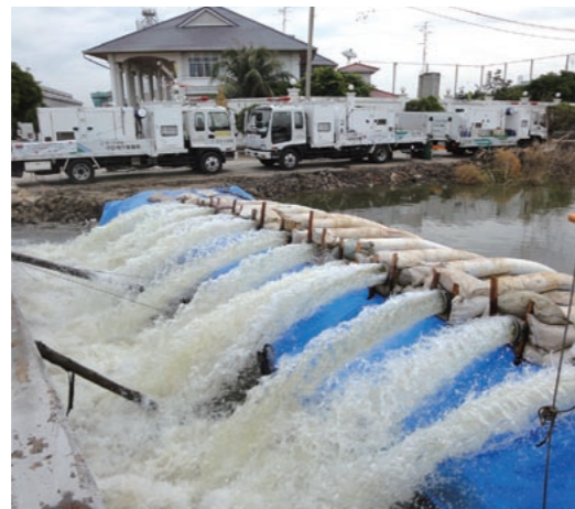
日本から輸送された国土交通省のポンプ車を使って排水作業を実施
