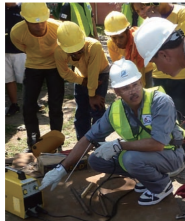
早期に復旧を進めるため、日本人専門家が溶接の技術を指導
