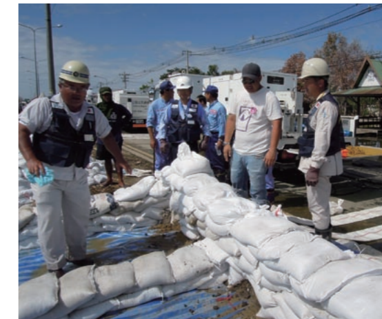
タイの作業員に排水ホースの設置を指導する日本人専門家
