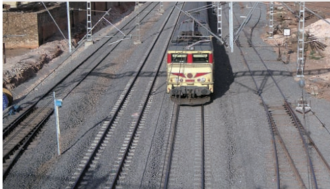
複線化された線路
