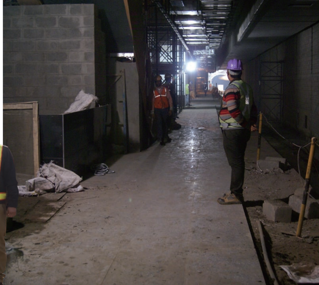
地下工事の進むジャマ・マスジッド駅。完成すると、ここはホームになる
