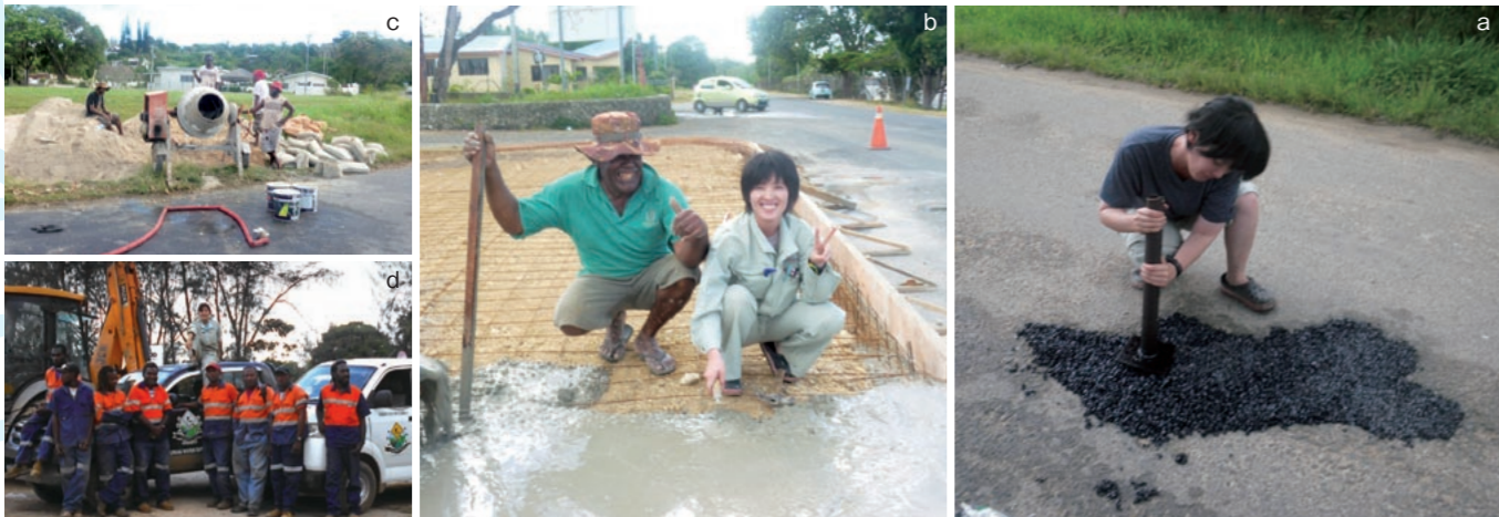
a.穴が開いてしまった道路の整備。せっかく整備しても、大雨などで舗装が壊れ、再整備が必要になることが多い b.現地スタッフと一緒に作業。自分ができそうなことを見つけて積極的に取り組んでいる c.現地には一通りの道具はそろっている d.職場の仲間たちと。離れた地域では泊まり込んで道路整備などを行う、熱心な職員が多い
