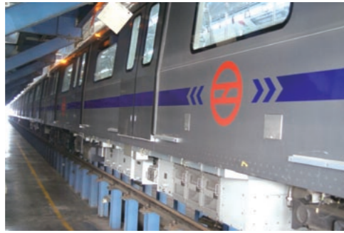
三菱電機の補助電源装置は車両の床下に取り付けられている
