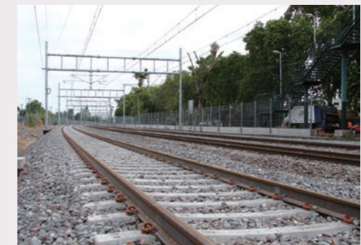
修復された軌道や架線
