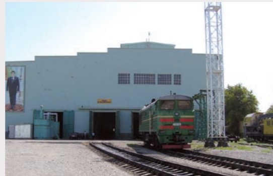
新しい設備が導入されたアシガバット機関車修理工場
