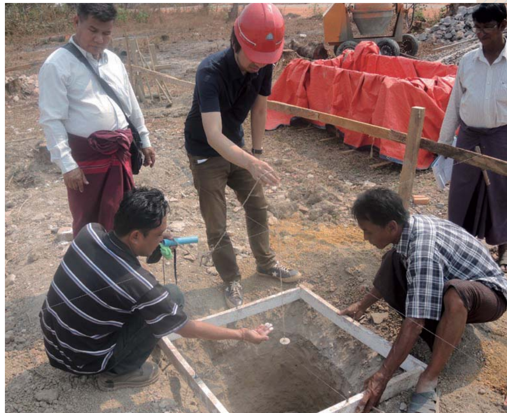
コミュニティセンターの建設現場(カレン州)。河村さんは、県職員時代に公共事業を管理していた経験を生かして、設計内容の打ち合わせや工程管理にも携わった
