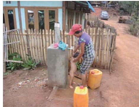
給水のパイロット事業で整備された公共水栓。子どもたちが遠くまで水くみに行く必要もなくなった
