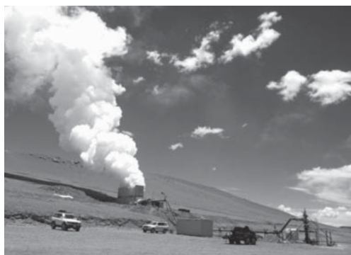
ボリビア勤務時代に担当した「ラグナ・コロラダ地熱発電所建設事業」。地熱井戸の蒸気噴気試験の様子
