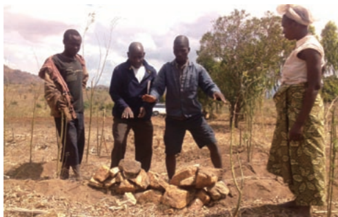
マラウイの農民たちは、傾斜が急な地形の耕作地で土壌流出を緩和するため、石を集めて「小規模ダム」を作った。一つ一つの小さな手作りダムの効果には限りがあるが、住民が協力して多くのダムを作ることで、効果を高めることができる
