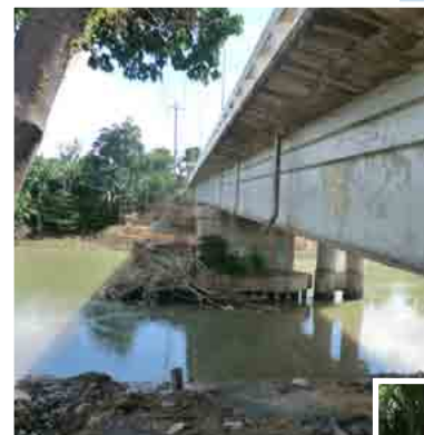
上：橋脚は川の流れに影響をおよぼしうる。橋脚に引っかかった流木が水の流れを妨げている。右：現在は基礎調査として、河川・地形の測量、雨量解析などのデータ集めや、住民への聞き取りが行われている。
