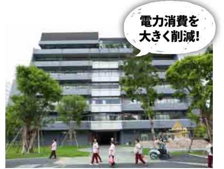
バンコク都庁 (BMA) 公共事業局の庁舎。約2年かけて省エネ対策を含むリノベーションを行い、今後は太陽光パネルも設置予定だ。
