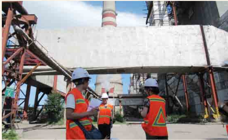
2016年度の中学生の部の入賞者はモンゴルで第4火力発電所を視察した。
