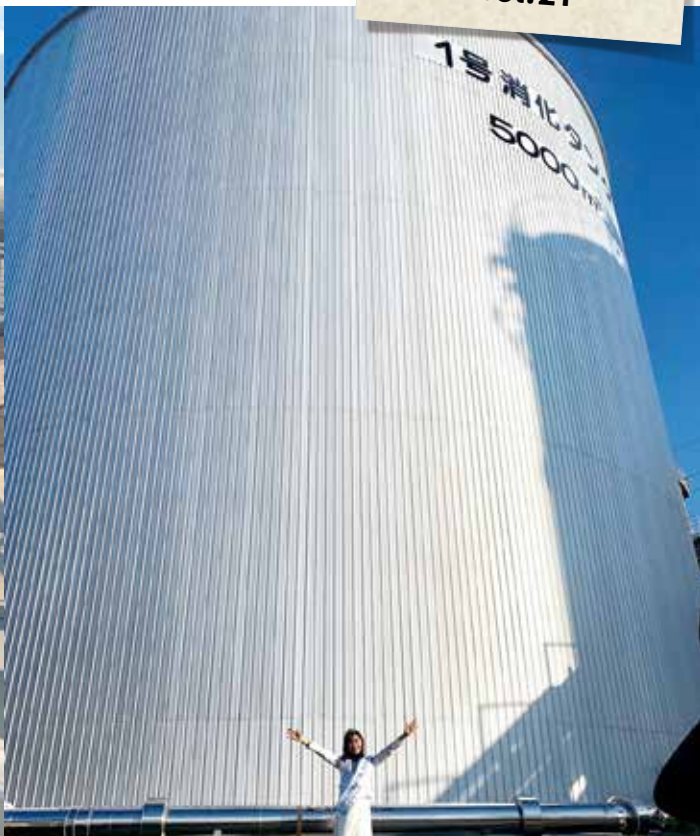
埼玉県元荒川水循環センターを見学する中村さん(左)。汚泥は消化タンク(右)で減量・安全化され、得られたガスで発電も行っている。
