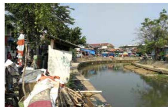
左：住宅近くにも流れる川にも生活排水が流れ込んでいて、浄化が課題だ。 右：未処理の生活排水が直接流れ込み水面には泡が。
