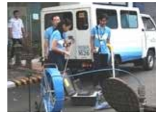
水道管の漏水箇所を特定するデモンストラーション。
