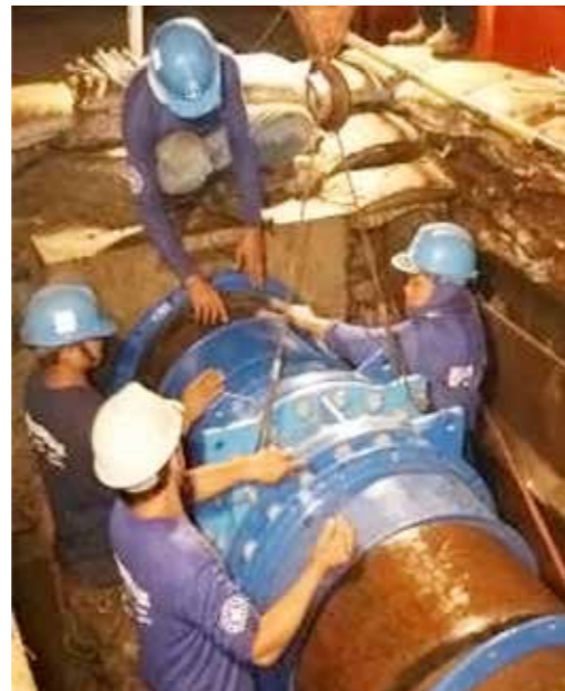
水道管を新しいものに更新する工事。
