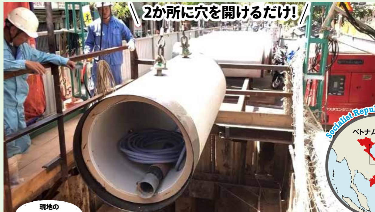
ホーチミン市の、推進工法を取り入れた下水管新設工事の現場。
