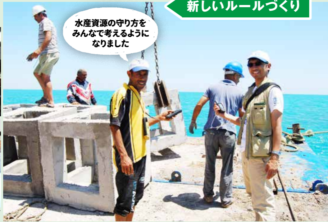
ガバース湾で違法操業対策や魚類の繁殖のために行った人工漁礁設置作業。
