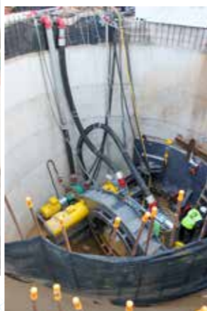
豪雨などで道路が冠水しないように雨水管を設置する。
