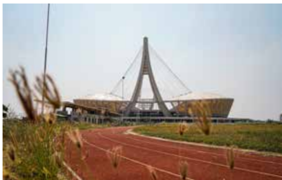
2023年のシーゲームスに向けてプノンベン郊外に建設中の複合型スポーツ施設。
