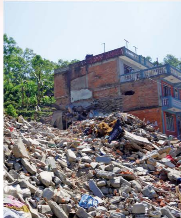
強い住宅を徹底させる行政の力が住民を守ることにつながる。不十分であっても鉄筋や梁があることで倒壊せず残った建物(奥)と、瓦礫と化した庶民建築(手前) (ネパール2015年5月)
