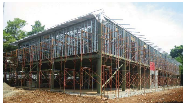
建設中止命令を受けた際の 現場事務所建設状況
