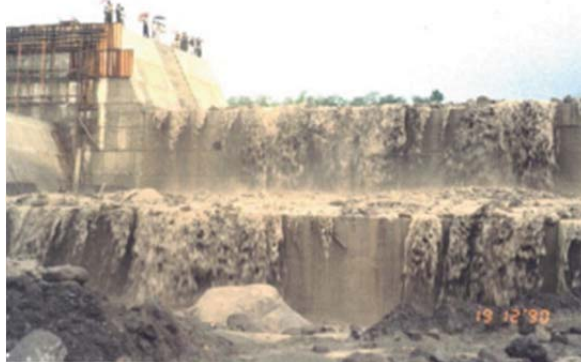
土石流を受けている鋼製 ダブルウォールダム
