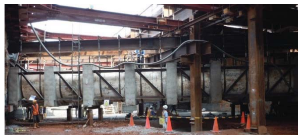
水道管（推進管）防護状況
