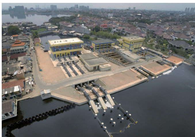
Stasiun Drainase Pluit (Foto: JICA)
