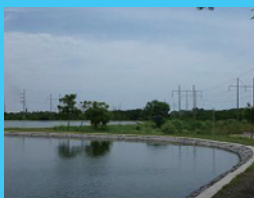
Tempat Pengolahan Air Limbah di Denpasar (Foto: Setelah Laporan Evaluasi JICA)
