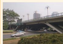
Proyek Jalan Layang Simpang Semanggi (Foto: Kenshiro Imamura/JICA)
