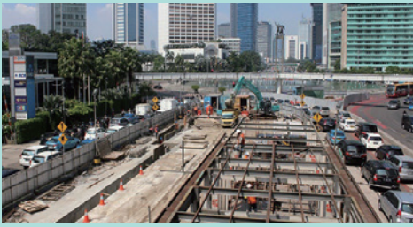
1: Pengerjaan konstruksi di dekat stasiun Bundaran HI
