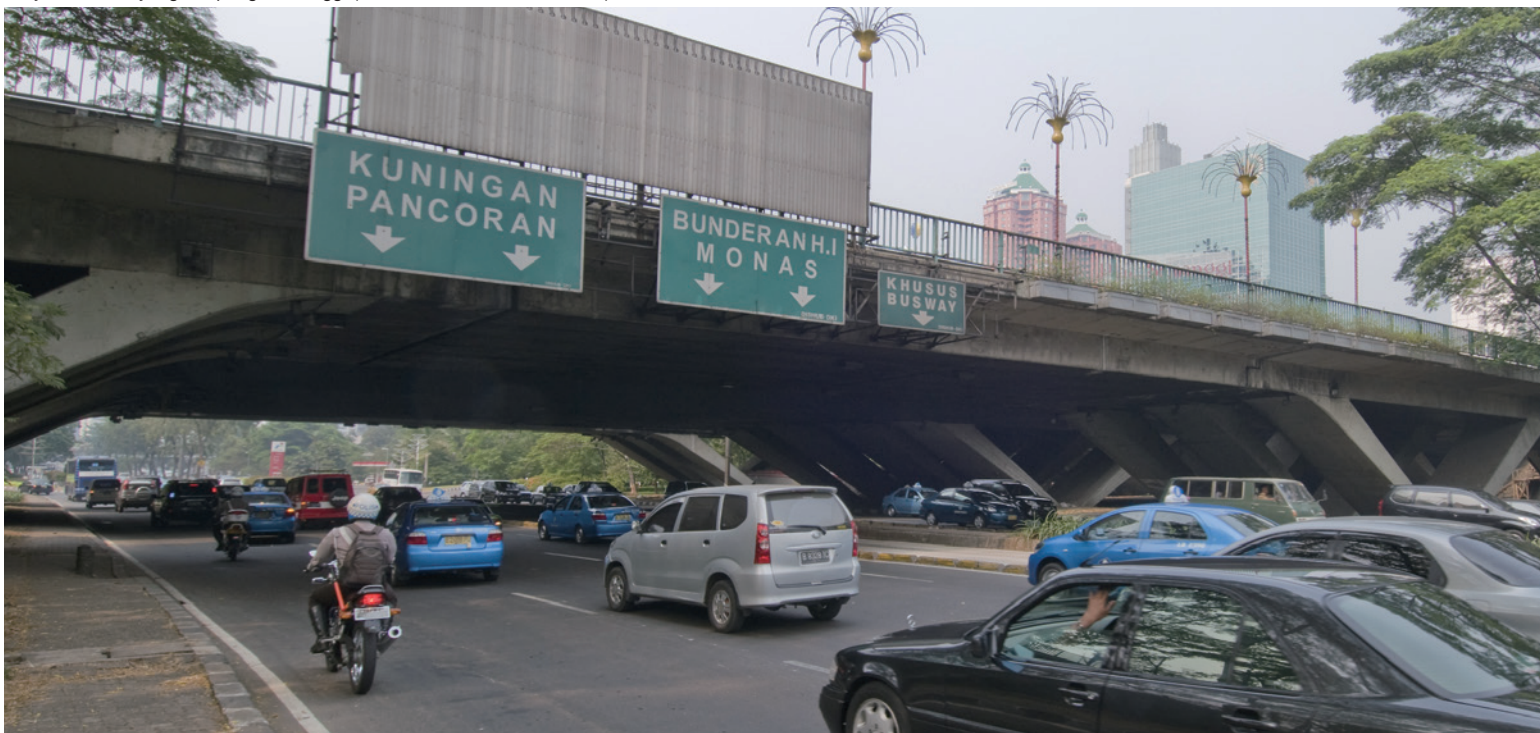
Proyek Jalan Layang Simpang Semanggi (Foto: Kenshiro Imamura/JICA)
