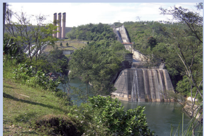
Bendungan Karangates (dilihat dari hilir ke hulu)(Foto: Nippon Koei Co., Ltd.)
