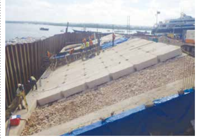
Baada ya kazi za ujenzi kuanza (Machi 2020)- Soko la Samaki Zanzibar
