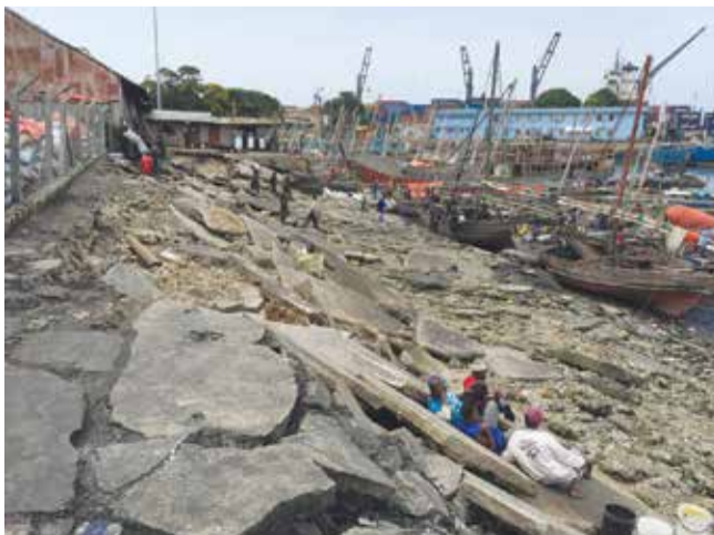
Kabla ya kuanza kazi za ujenzi (Desemba 2015)- Soko la Samaki Zanzibar
