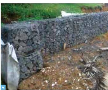
【4】崩壊した斜面への復旧対応の一つ「蛇籠工法」です。
