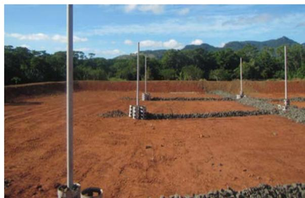
写真2. フィジー ランバサで導入された準好気性埋立構造（福岡方式）の処分場
