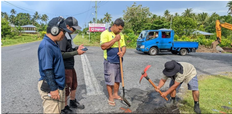
漏水発見後すぐに漏水修理をするサバイ課 NRW 職員
