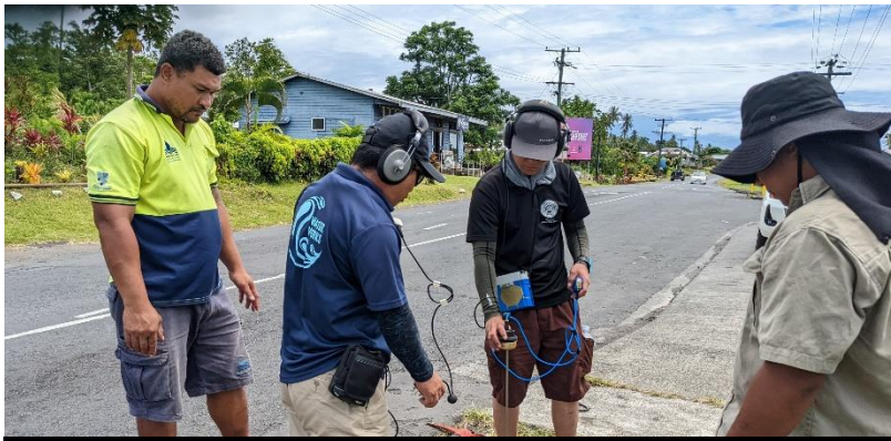
漏水探知実習に漏水箇所発見
