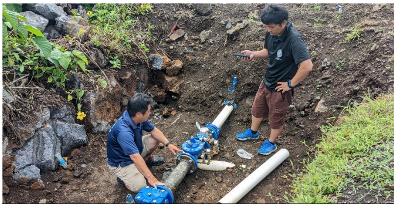
DMA4 の施工状況を確認する仲間、有銘専門家
