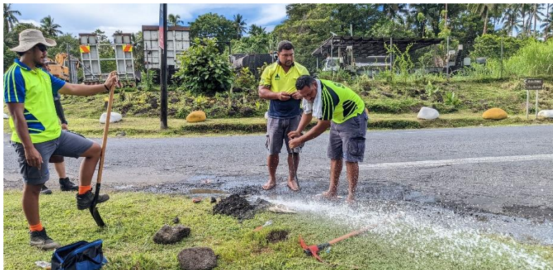
漏水修理をするサバイ課 NRW 職員
