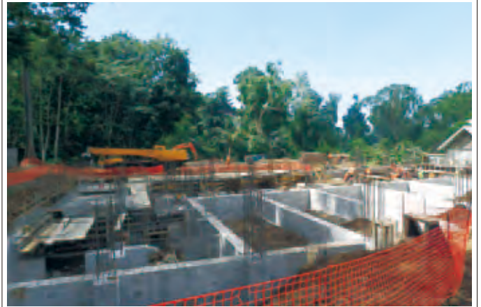
太平洋気候変動センター建設計画 工事の様子
