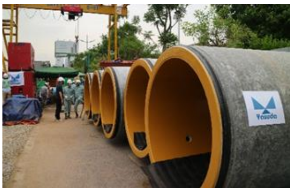
特殊コーティングが施された直径約1.5mの下水管（推進管）
