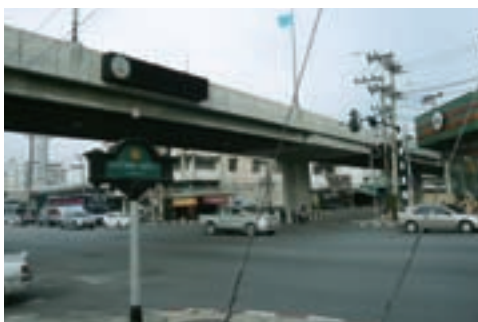
建設された高架橋
