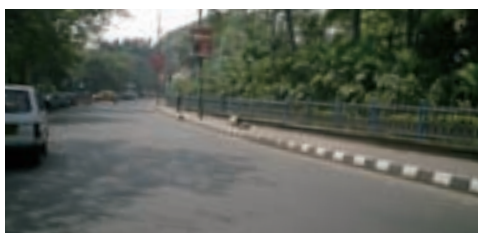
追加工事区間
