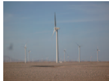
本事業により建設された風力発電所
