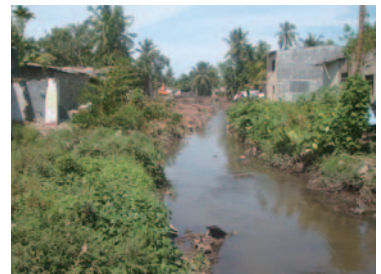
事業実施前の排水路（2002年撮影）
