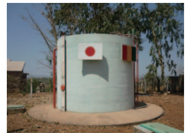
管路系給水施設の給水タンク
