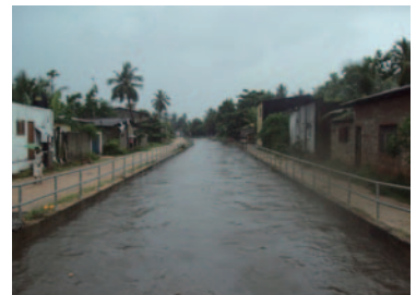
事業実施後の排水路
