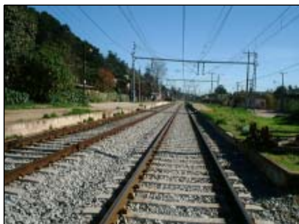
サイト写真：修復後の軌道・架線（バルパライソ）
