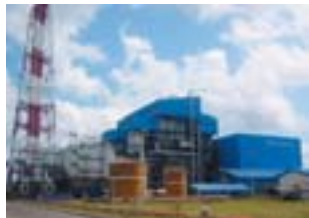
バンジャルマシンの石炭火力発電所。同発電所は、カリマンタン島にある南カリマンタン州に位置し、同地域の重要な発電拠点となっている。
