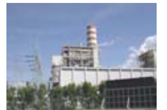
マシンロック石炭火力発電所(300MW×2基)は、1998年に稼働を開始し、定期的にモニタリングが行われている。
