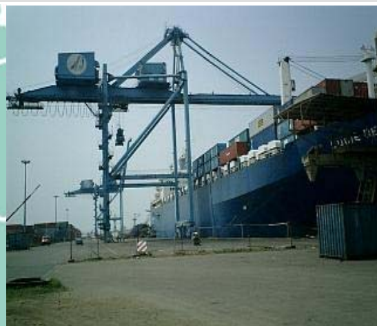
ドゥアラ港のコンテナクレーン
