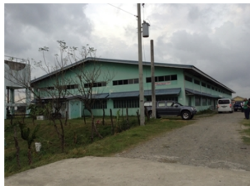
写真 6：Pangasinan 州 Manambong Sur バランガイ避難センター
