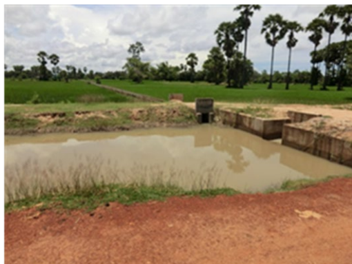
写真2: TSC2モデルサイト。2次水路の補修とともに3次水路もコンクリート舗装された。雨期稲作の後には奥のココナツから砂糖原料となる樹液を採取する。
