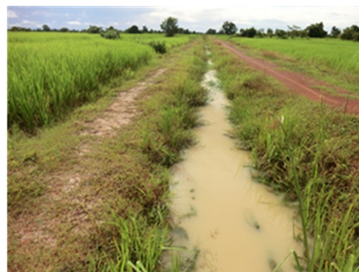
写真 7: TSC3 のモデルサイトの水稲作 (2 次水路を挟んで左側)。灌漑施設改修と営農指導により、右側のサイト外側のものより生育が勝り、生育ムラも少ない。
