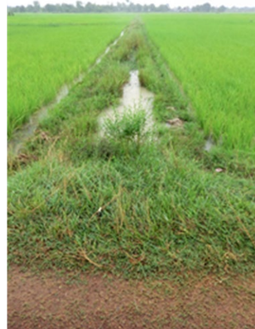
写真6：モデルサイトの外の農民達が自力で掘り進めた3次水路。道路に暗渠を設けてモデルサイトの3次水路とつないでいる。
