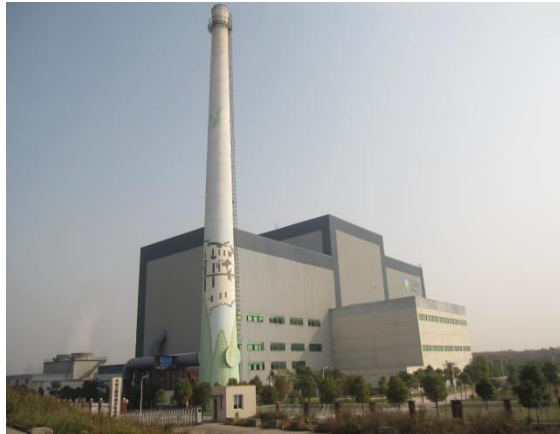
建設された生活廃棄物焼却施設（安徽省） （写真：事後評価報告書）
