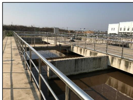
河南省南陽市の汚水処理場
