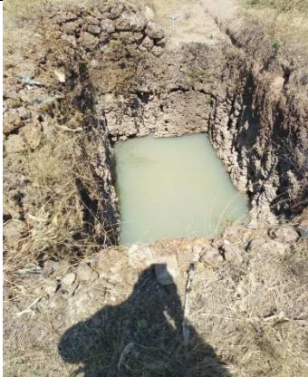
上部の覆われていない浅井戸
