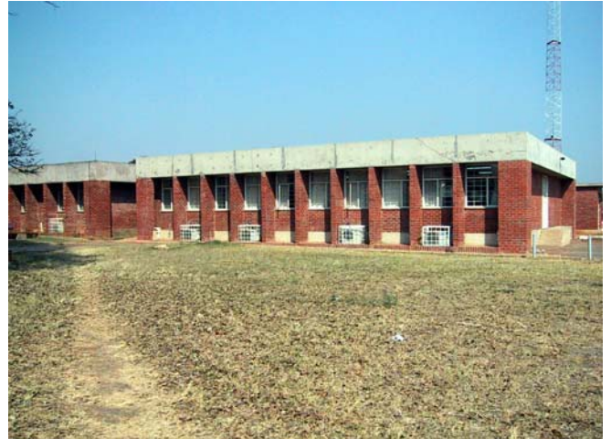
ザンビア: UTH ウイルス検査室・結核検査室外観
