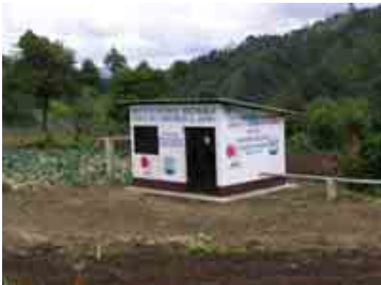
⑨ 灌漑事業で設置された、灌漑ポンプ。維持管理は灌漑委員会によってされている。
