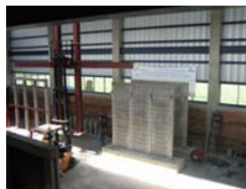
エルサルバドル・中米大学で建設中の耐震実験ラボ。
