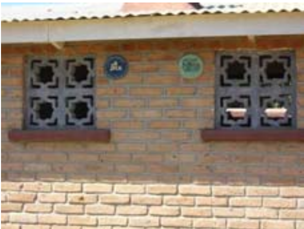
NIPDEP で建設した学校
