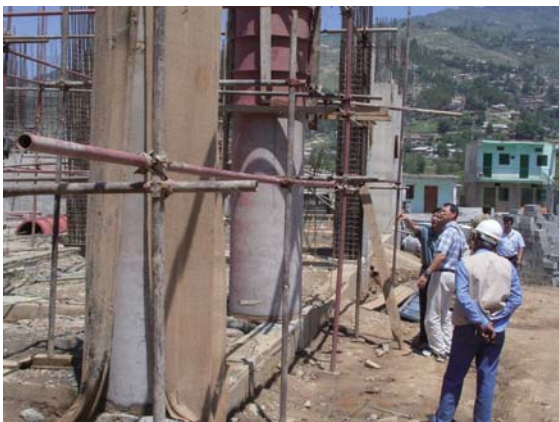
DHQ 病院の再建現場
