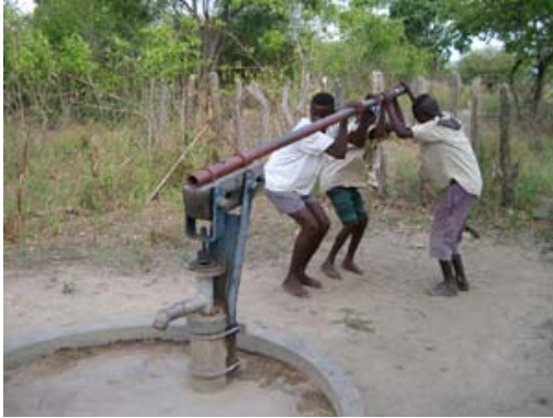
写真1 Dambaの深井戸
